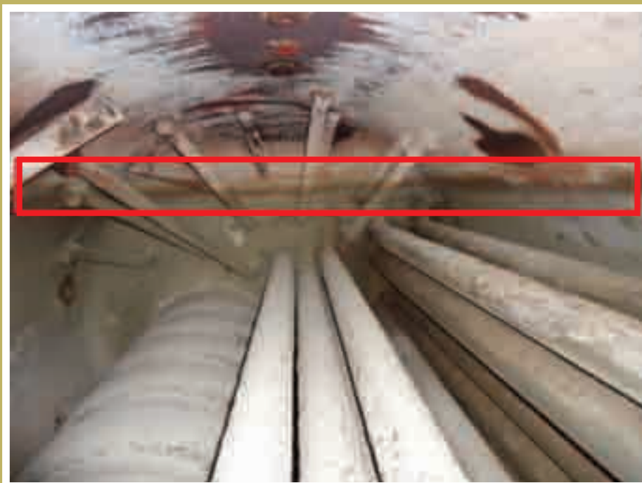
Figura 2: vista interior de una caldera humotubular, donde puede apreciarse la zona de trabajo del nivel de líquido dentro del recuadro en color rojo.
