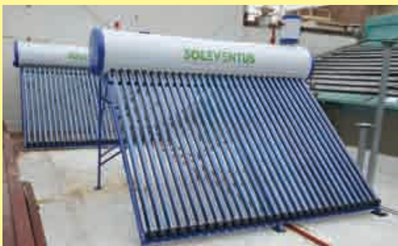
Foto: Termotanque solar en techo de hogar de niños en Barracas, CABA. Gentileza Soleventus
