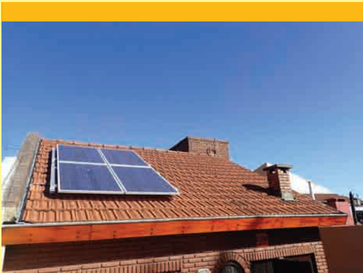
Foto: Instalación Solar Fotovoltaica 1kW Offgrid en CABA. Back Up con Generación. Gentileza Efergía
