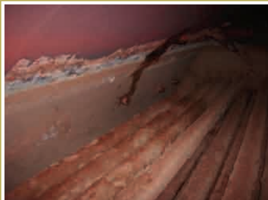
Figura 3: interior de otra caldera humotubular de 3 pasos. Zona de tubos muy incrustada y demarcada en rojo la zona de fluctuación del nivel líquido.
