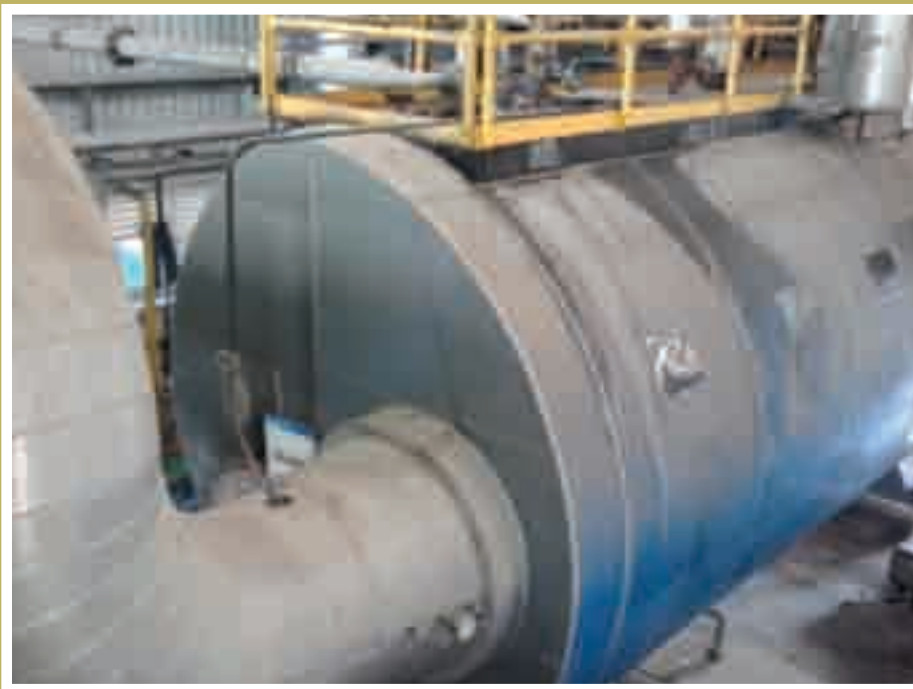
Figura 4: caldera industrial con ventanas laterales para medición de espesores a la altura del nivel de agua.
