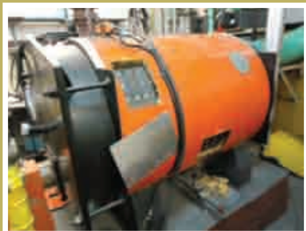
Figura 5: imagen de la caldera con las ventanas de medición practicadas en sus laterales.
